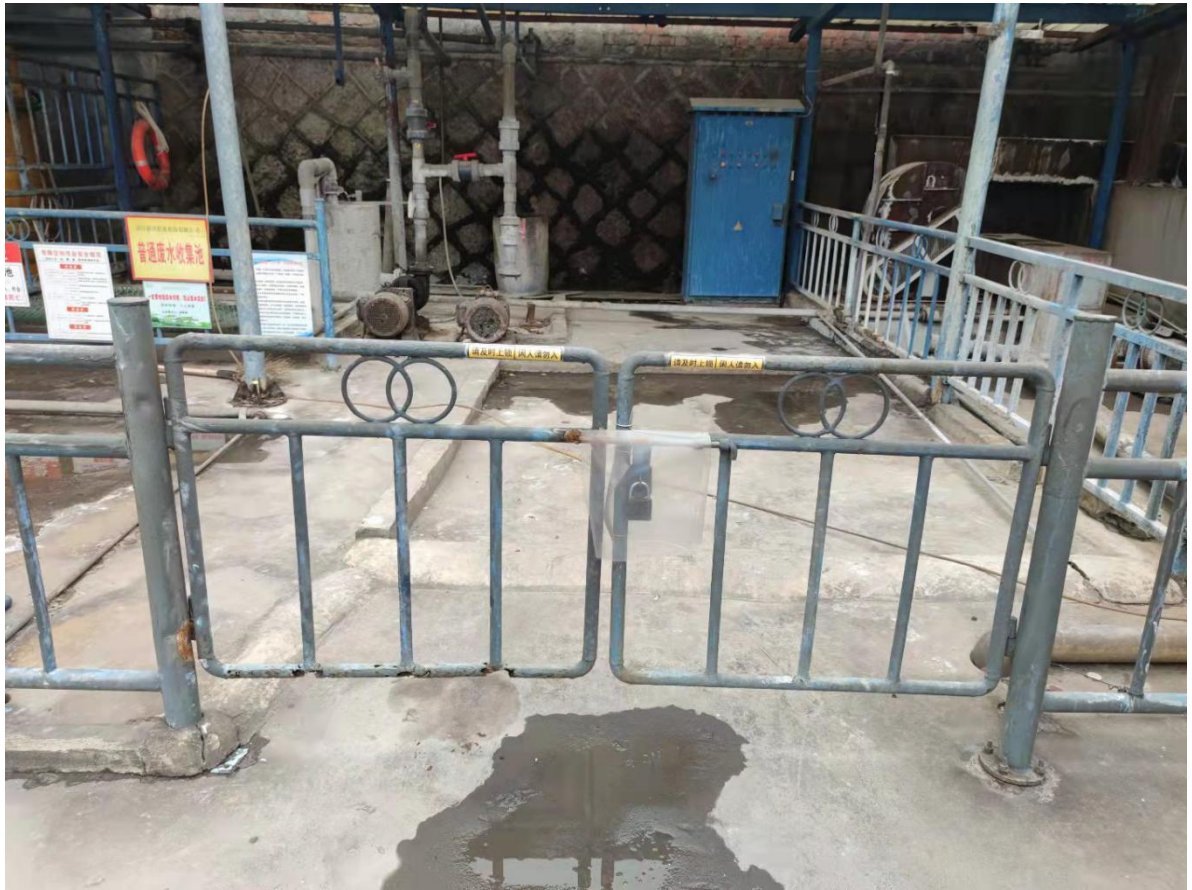
废水收集池现状照片
